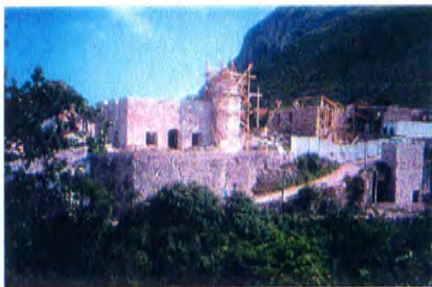
Džamija tokom obnove, June 1999
